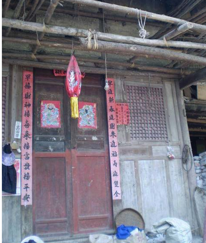
傳統木造住宅
