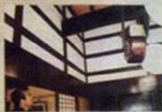
木組みを組むのは、柱と横材を組み合わせたジャンブルジムのような構造で力を分散し、木を組んで壁木を打ち込んだ太い柔軟な接合部で、木組みが滑ったり、めり込んで力を受取る
