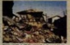
阪神・淡路大震災で倒壊を免れた民家。「通し貫」で持ちこたえている (日本建築学会編「日本の地震対策」より)
