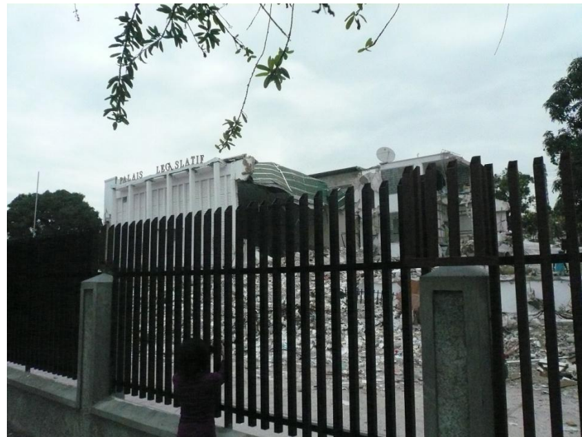
倒壊した国会ビル
