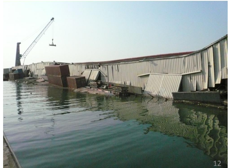
被害を受け水没する港湾施設
