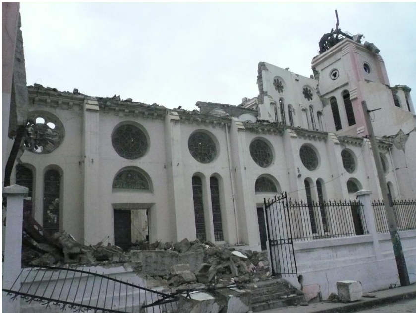
ポルトープランス教会(屋根が崩落、 大司教も死亡)
